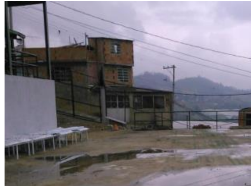
Tanque de Almacenamiento No 2
