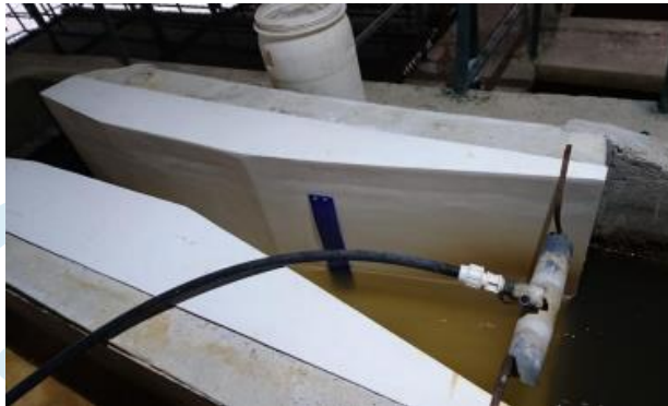
Ilustración 7. Canaleta Parshall
