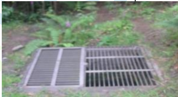
Ilustración 5. Cámaras de quiebre
