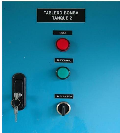
Los tableros tienen la función de activar o encender la motobomba que se requiera. También cuentan con un botón de mando para activar la motobomba de manera automática o modo manual, un testigo de color verde que indica cuando está encendida la motobomba o se encuentra en funcionamiento y otro testigo de color rojo que indica que hay un nivel bajo de agua en el tanque de almacenamiento, casos en los cuales el funcionamiento de la motobomba se detiene.
